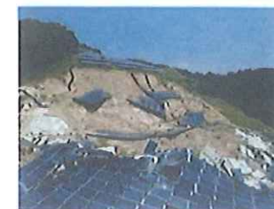
土砂崩れで生じた崩落
